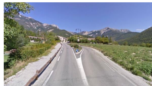
Ilot central en entrée de village
