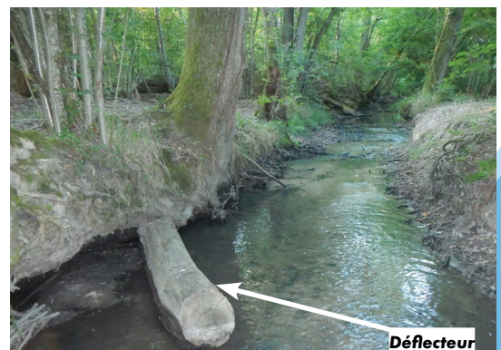
Après travaux (le 23 juillet 2019)
