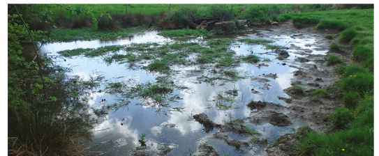
Avant travaux (août 2018)
